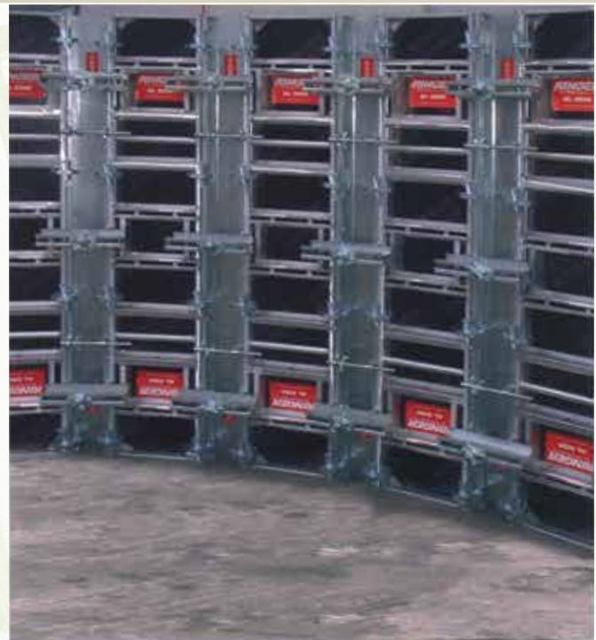
AL 2000 Szalunki do ścian okrągłych Projekt "METEOR" w Moskwie
