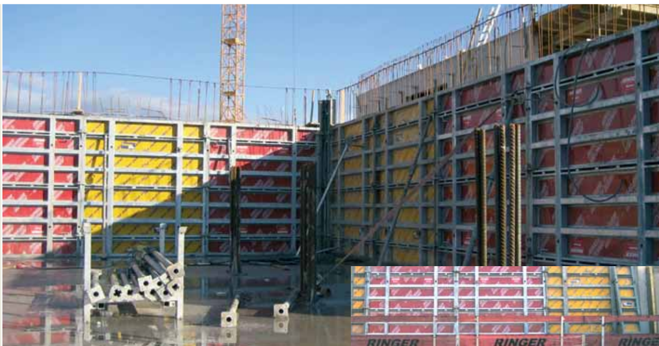
Salzburg - realizacja projektu
