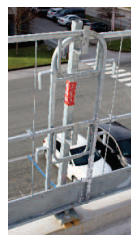
z butem barierki i słupkiem barierki, mocowanym za pomocą kotwy lub kołka 16 mm
