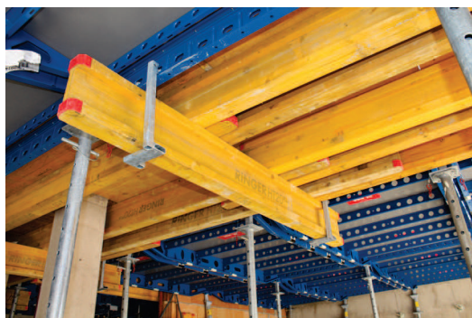
Szybkie zamknięcie przez elementy równoważące dźwigarem, bez dodatkowych podpór
