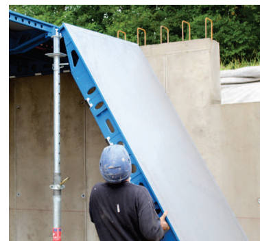
Optymalna obsługa, przez ergonomiczne, ręczne uchwyty w profilu wzdłużnym
