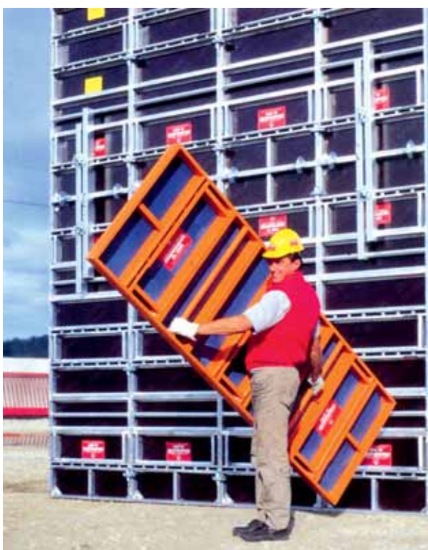
Fot. 1. Pojedyncze panele deskowania Ringer AL2000 może przemieścić jedna osoba
