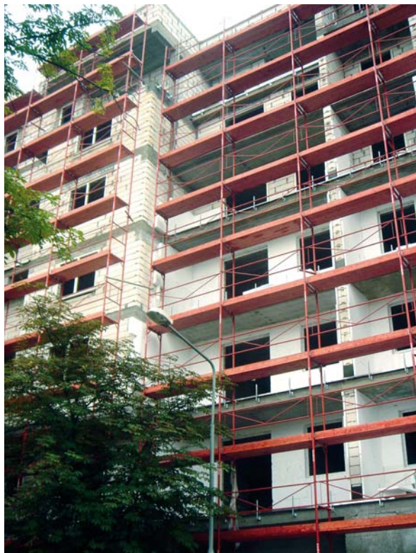
Budowa w Poznaniu
