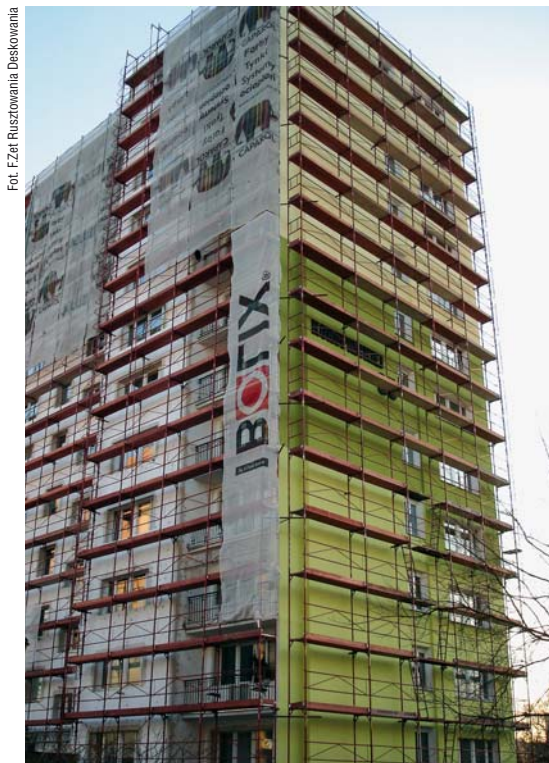
Remont osiedla budynków wielorodzinnych w Bydgoszczy
