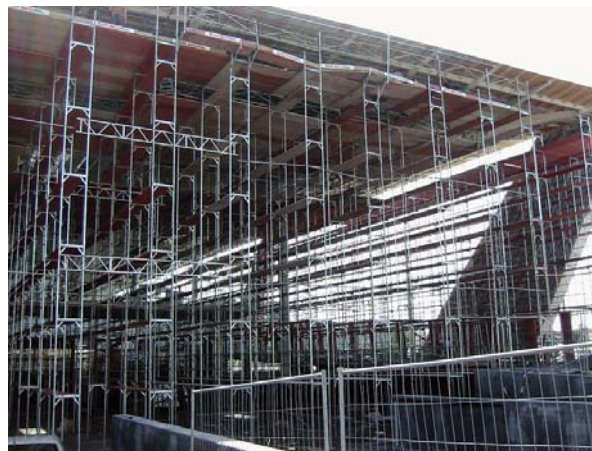
Budowa fabryki Mercedesa w Austrii
